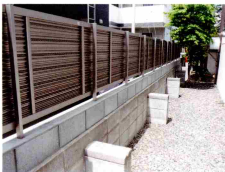
ブロック塀補修
